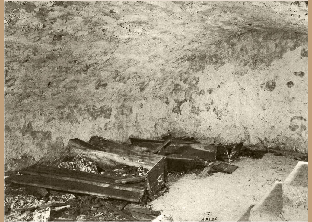
Zustand der Gräber 1940
