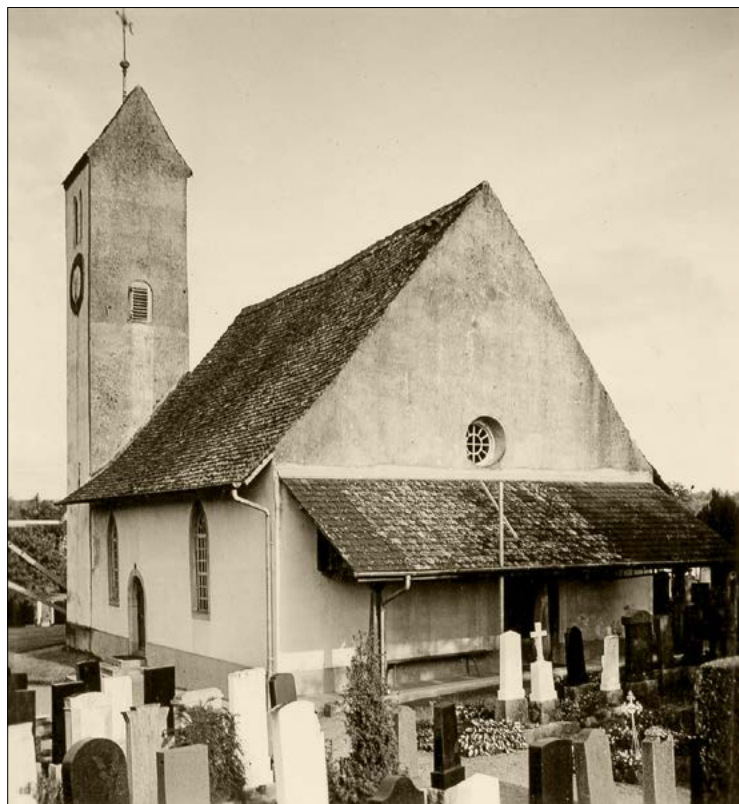
Ansichten der alten Kirche Möriken von Nordwesten; bemerkenswert ist das Vordach, welches beim Neubau «übernommen» wurde.
