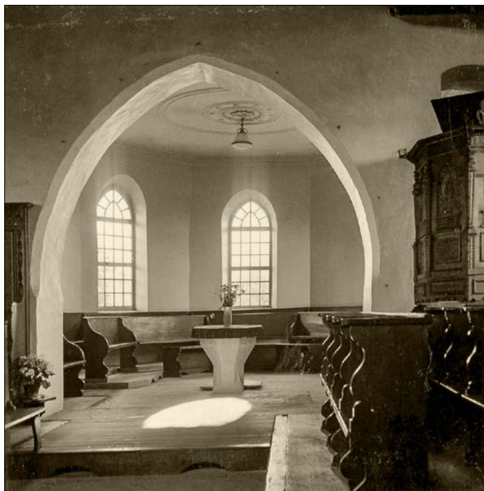
Chor und Taufstein von 1554 kurz vor dem Abbruch.
